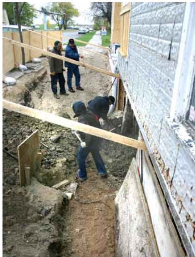
H.P. Tergesen and Sons General Merchant, Gimli (Manitoba) Intégration d'améliorations énergétiques à des travaux de réparation indispensables.
