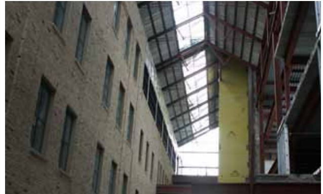
Red River College (Campus de la rue Princess), Winnipeg (Manitoba) La ruelle historique a été conservée sous forme d’atrium en verre. Les nouvelles technologies peuvent faire bon ménage avec les anciennes lorsqu’on vise l’excellence énergétique.
