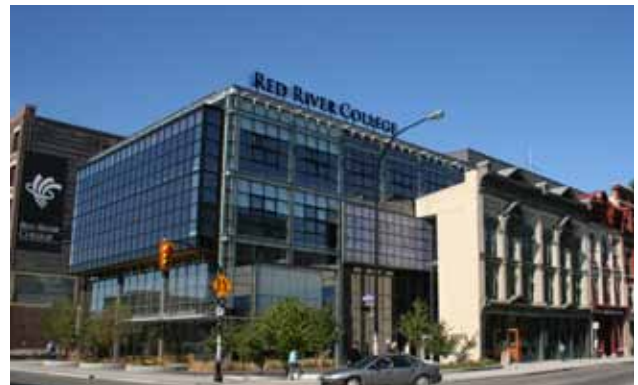
Red River College (Campus quartier de la Bourse), Winnipeg (Manitoba) Les façades des édifices historiques le long de la rue Princess ont été intégrées au nouveau complexe plutôt que démolies.
