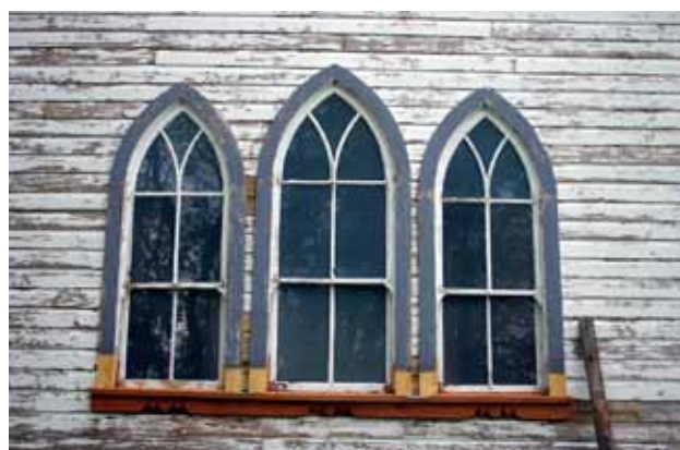
Église anglicane St. Paul, région de St-Francois-Xavier (Manitoba). Les encadrements de fenêtre sont conservés et réparés en intégrant des matériaux nouveaux assortis aux anciens.
